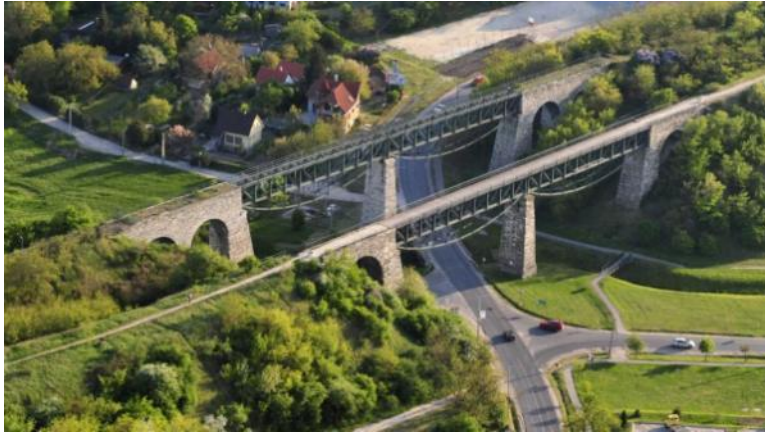
La du viaduktoj
